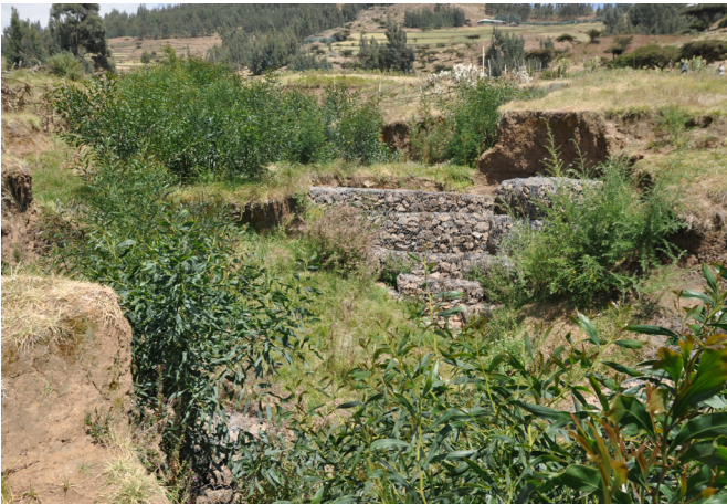
Mit Stein gefüllte Drahtkörbe werden in die Gräben eingebaut.
