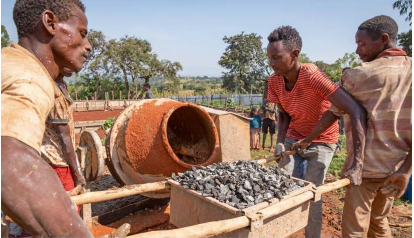
Für das Fundament der neuen Schule in Kemeso Arere vermengen Buzuna Tasisa (2.v.r.) und zwei Arbeiter Kies, Zement, Sand und Wasser zu Beton.
