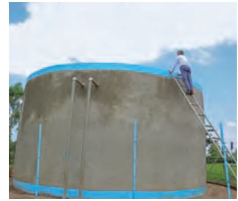
Vorstandssprecher Dr. Sebastian Brandis besichtigt das Reservoir des neuen städtischen Wasserversorgungssystems von Seyo.
